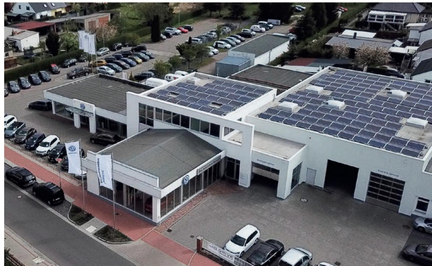
Die bestehende PV-Anlage mit 99kWp-Leistung auf dem Dach des Autohauses
